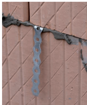
21. Lehajtott helyzetű bekötőszalag
