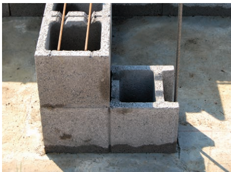
5. Falsarok kialakítása
