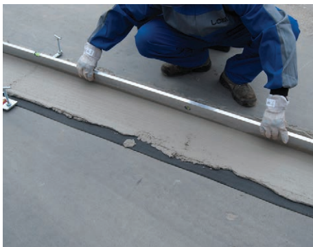
8. Kezdősor alatti habarcssáv kialakítása
