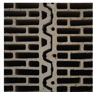
1. Szorosan illesztett hornyeresztékes kapcsolat
