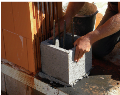
9. Első pillérzsaluzó elem elhelyezése
