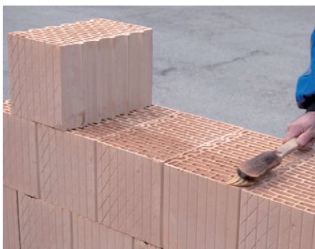
13. LeierPLAN falazóelem előnedvesítése ragasztás előtt
