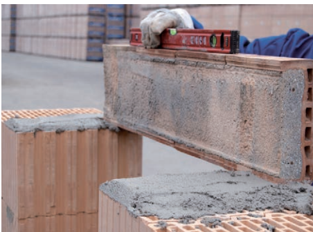
43. Felfekvési felület LeierPLAN falszerkezet esetén
