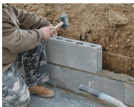
4. Válaszfalelem beállítása
