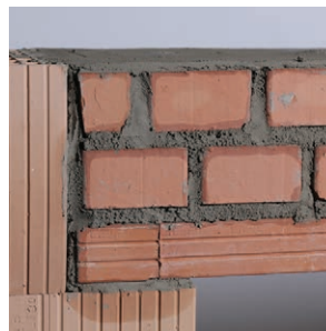
52. Felső sík kialakítása LeierPLAN falszerkezet esetén
