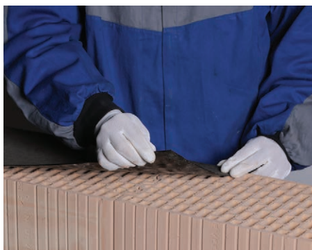
18. Falszerkezet lezárása bitumenes szigetelőlemezzel
