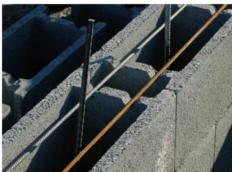
7. Függőleges és vízszintes vasalás betonzás előtt
