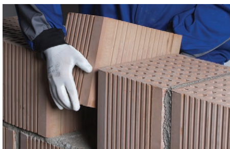
37. Vágott elem elhelyezése hanggátló falba (25/30 AKU)
