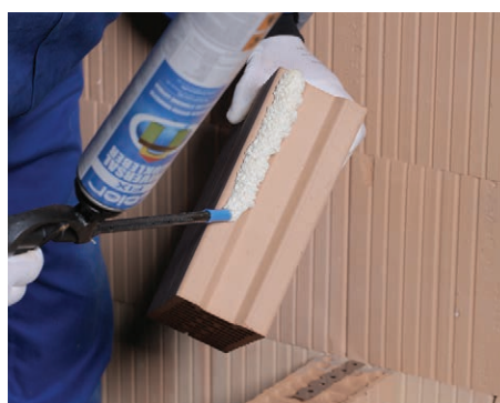
26. Ragasztó felhordása az elem függőleges felületére falcsatlakozásnál
