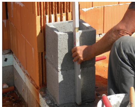
10. A függőleges ellenőrzése
