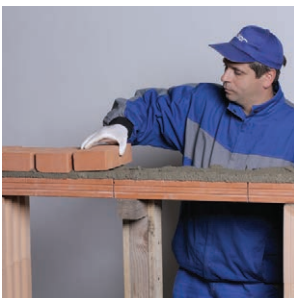
50. Nyomott öv falazása
