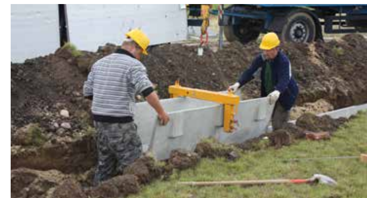
a speciális emelőszköznek köszönhetően, rendkívül hatékony az elemek beépítése
