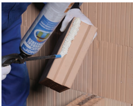
26. Ragasztó felhordása az elem függőleges felületére falcsatlakozásnál
