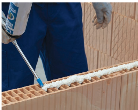
24. LeierFIX univerzális építési ragasztó felhordása a válaszfalelem középső bordájára
