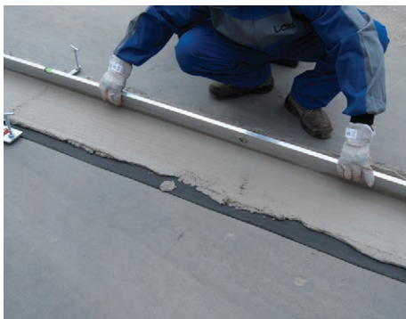
8. Kezdősor alatti habarcssáv kialakítása
