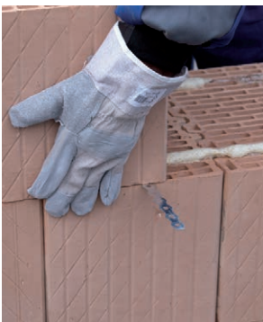
20. Falazóelem elhelyezése bekötőszalagos csatlakozásnál
