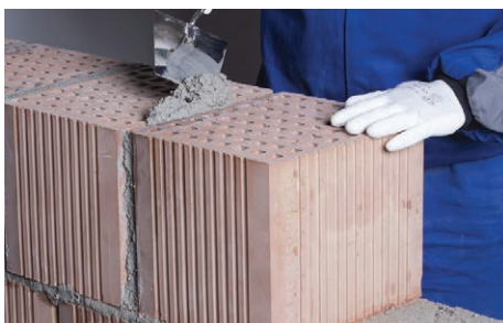
36. Hanggátló fal függőleges habarcshezag (25/30 AKU)
