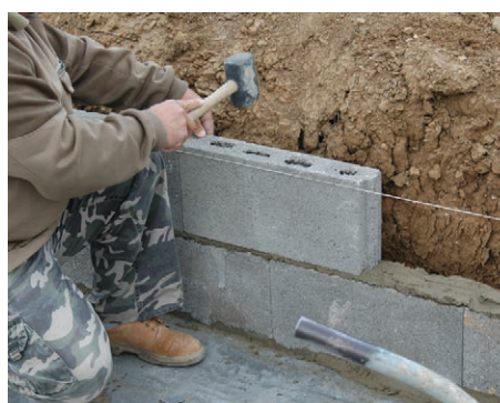
4. Válaszfalelem beállítása
