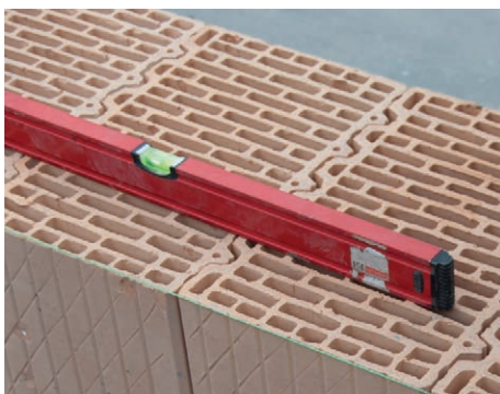
17. Faltest ellenőrzése vízmértékkel
