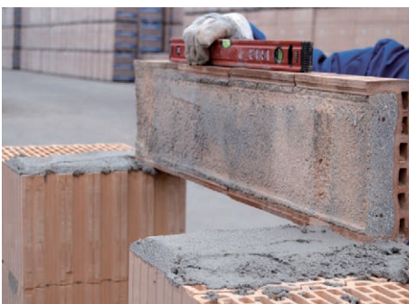
43. Felfekvésí felület LeierPLAN falszerkezet esetén
