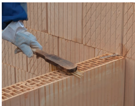
23. LeierPLAN válaszfalelem előnedvesítése
