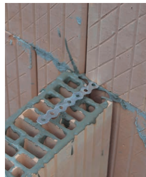
22. Válaszfalelemre hajtott bekötőszalag
