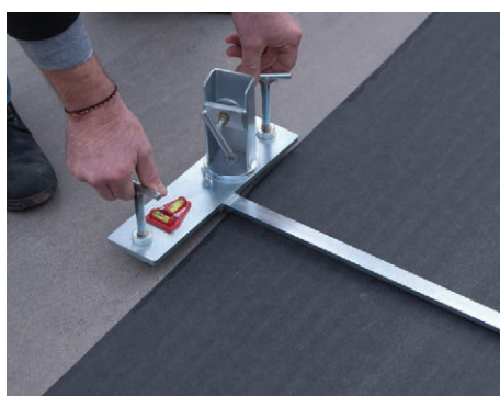
6. Szint beállítása a nivelláló készleten
