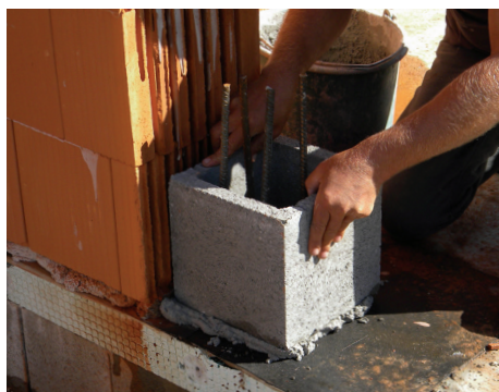
9. Első pillérzsaluzó elem elhelyezése
