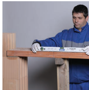
49. Vízszintes helyzet ellenőrzése
