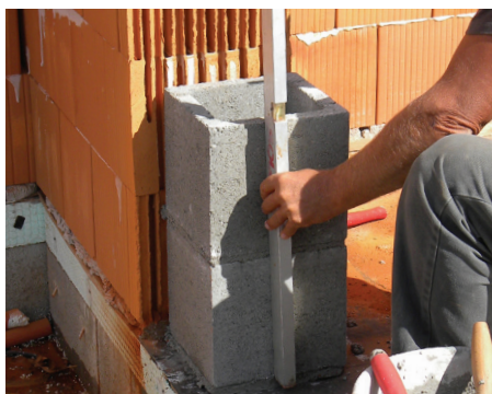
10. A függőleges ellenőrzése
