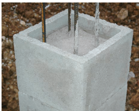
12. Kibetonozott pillérzsaluzó elem
