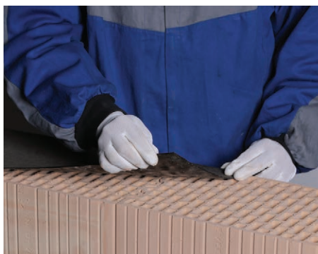
18. Falszerkezet lezárása bitumenes szigetelőlemezzel
